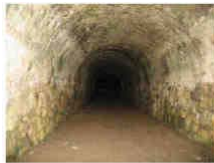
Tunnel d'entrée de la mine, cliché mairie
